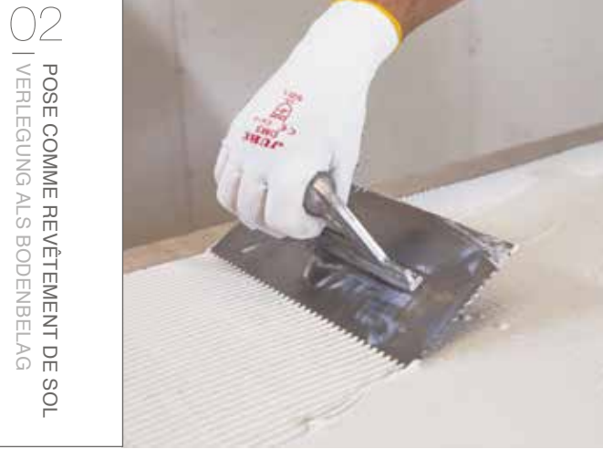
02 APPLIQUEZ LA COLLE AVEC UN DOUBLE ENCOLLAGE SANS LAISSER DE CREUX. D'ABORD AU REVERS DE LA PIÈCE À L'AIDE D'UN PEIGNE À DENTS PLATES DE 3 MM PUIS SUR LE SUPPORT AVEC UN PEIGNE À DENTS INCLINÉES DE 6 MM. EN ESSAYANT DE COUVRIR AUSSI LES ANGLES ET LES BORDS ET D'ÉVITER DES VIDES D'AIR ENTRE LE SUPPORT ET LA PIÈCE. 02 EINE DOPPELTE SCHICHT KLEBER OHNE FREIRÄUME ANBRINGEN, ZUERST AUF DER RÜCKSEITE DER PLATTE MIT EINER GLÄTTKELLE MIT FLACHER ZÄHNUNG (3 MM), ANSCHLIEßEND AUF DEM UNTERGRUND MIT EINER GLÄTTKELLE MIT GENEIGTER ZÄHNUNG (6 MM). DABEI SIND AUCH DIE ECKEN UND RÄNDER ZU BEDECKEN UND LUFTEINSCHLÜSSE ZWISCHEN DEM UNTERGRUND UND DER PLATTE ZU VERMEIDEN.
