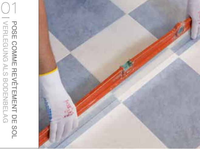
01 LE SUPPORT DOIT ÊTRE PARFAITEMENT PLAT. 01 DER UNTERGRUND MUSS VOLLKOMMEN EBEN SEIN.
