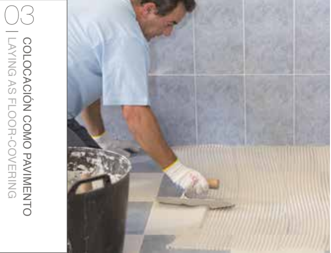
03 EXTENDER EL ADHESIVO, EN CADA OCASIÓN, SOLAMENTE SOBRE LA SUPERFICIE DE SOPORTE SOBRE LA QUE SE VA A COLOCAR LA PIEZA. NO APLICAR SOBRE SUPERFICIES MAYORES DE SOPORTE PARA EVITAR PERDIDAS DE ADHERENCIA. 03 SPREAD THE ADHESIVE EACH TIME ONLY OVER THE PART OF THE SUPPORT TO WHICH THE NEXT PIECE IS TO BE APPLIED; DO NOT APPLY TO LARGE AREAS IN ORDER TO AVOID LOSS OF ADHESION.
