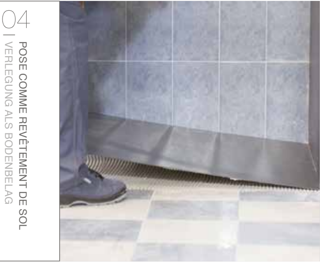
04 APPUYEZ DÉLICATEMENT LA PLAQUE PAR LE CÔTÉ LONG ET, EN LA MAINTENANT LÉGÈREMENT INCLINÉE, PLACEZ-LA EN L'ABAISSANT ET EN L'ADHÉRANT AU SUPPORT. 04 DIE PLATTE VORSICHTIG AUF DER LÄNGSSEITE ABSTÜTZEN UND LEICHT GENEIGT HALTEN. ABSENKEN UND AUF DEN UNTERGRUND KLEBEN.
