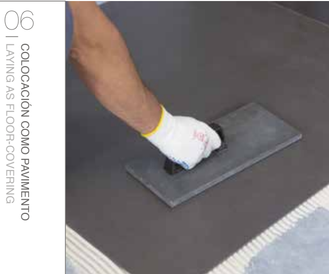
06 GOLPEAR EN LA SUPERFICIE UTILIZANDO UNA LLANA DE GOMA PROCURANDO ELIMINAR LOS HUECOS Y BURBUJAS DE AIRE. COMPROBAR SIEMPRE LA PERFECTA ADHESIÓN DE LAS ESQUINAS Y ARISTAS. NO PISAR EL PAVIMENTO DURANTE Y DESPUÉS DE LA COLOCACIÓN, RESPETANDO LOS TIEMPOS INDICADOS POR EL FABRICANTE DEL ADHESIVO. 06 BEAT THE SURFACE WITH A RUBBER FLOAT SO AS TO ELIMINATE AIR GAPS. ALWAYS ENSURE THAT THE CORNERS AND EDGES ARE COMPLETELY STUCK. DO NOT WALK ON THE FLOOR DURING OR IMMEDIATELY AFTER LAYING; WAIT FOR THE NECESSARY TIME ACCORDING TO THE ADHESIVE MANUFACTURER'S INSTRUCTIONS.
