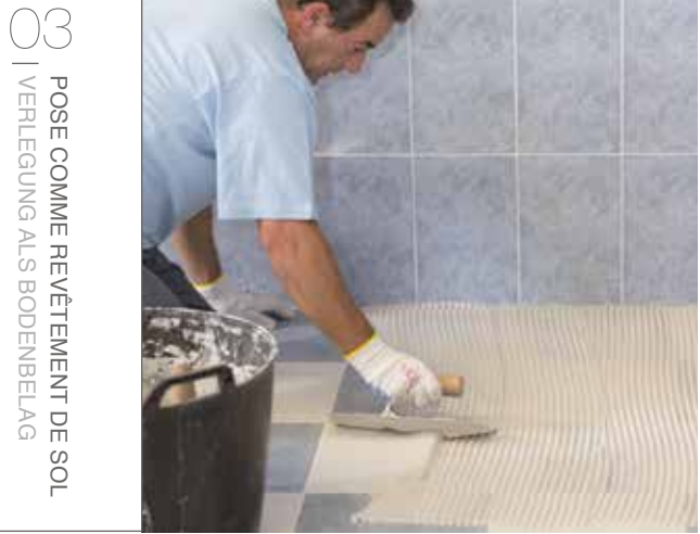
03 ÉTALEZ LA COLLE, À CHAQUE FOIS, UNIQUEMENT SUR LA SURFACE DU SUPPORT SUR LEQUEL SERA PLACÉE LA PIÈCE. NE L'APPLIQUEZ PAS SUR DES SURFACES PLUS GRANDES QUE LE SUPPORT POUR ÉVITER DES PERTES D'ADHÉRENCE. 03 DEN KLEBER JEWEILS NUR AUF DER FLÄCHE DES UNTERGRUNDS VERTEILEN, AUF DER DIE PLATTE VERLEGT WIRD. NICHT AUF GRÖßEREN UNTERGRUNDFLÄCHEN VERTEILEN, UM HAFTUNGSVERLUSTE ZU VERMEIDEN.
