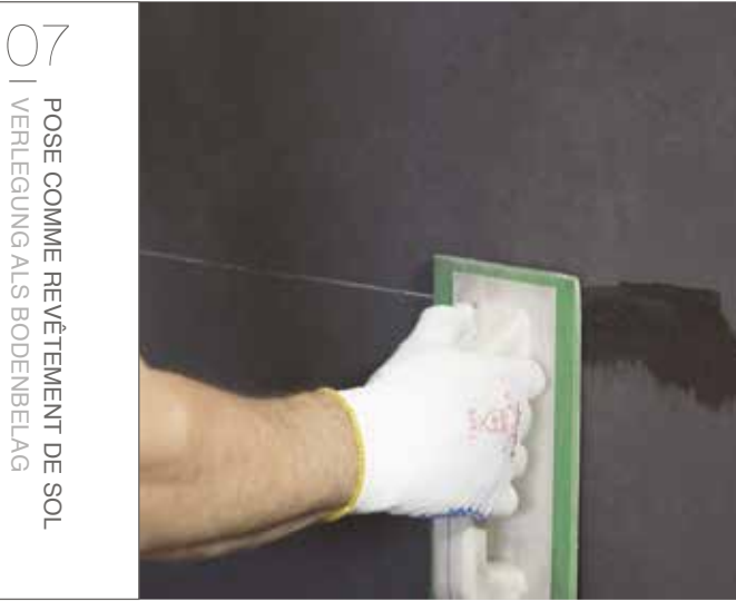
07 AVANT DE PROCÉDER AU JOINTOIEMENT, IL FAUT RESPECTER LES TEMPS INDICUÉS PAR LE FABRICANT DE LA COLLE : IL EST POSSIBLE D'UTILISER DES PRODUITS À BASE DE CIMENT OU DE RÉSINE ÉPOXYDIQUE. CES DERNIÈRES GARANTISSENT UNE PLUS GRANDE UNIFORMITÉ ET LA CONSERVATION DE LA COULEUR AU FIL DU TEMPS. 07 VOR DER VERFUGUNG MÜSSEN DIE VOM HERSTELLER DES KLEBERS ANGEgebenEN ZEITEN EINGEHALTEN WERDEN: ES KÖNNEN PRODUKTE AUF ZEMENT- ODER EPOXIDHARZ-BASIS VERWENDET WERDEN. LETZTERE GEWÄHRLEISTEN GRÖßERE GLEICHMÄSSIGKEIT UND LÄNGERE FARBECHTHEIT.
